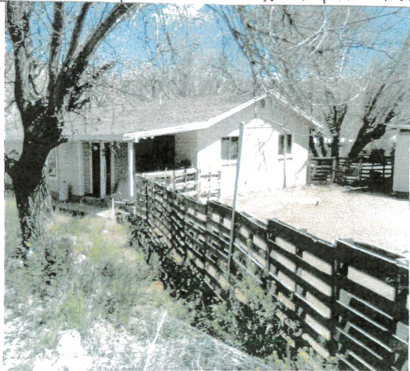
SIDE LOOKING N.
